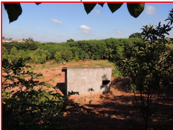
Figura 13: Construção parada na área descampada
