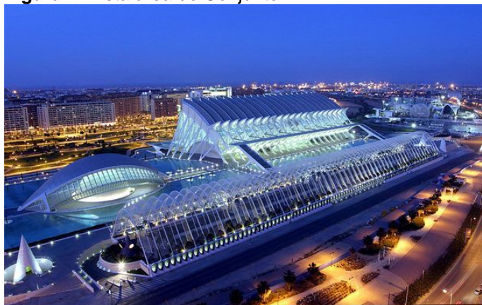
Figura 4. Vista área do Conjunto.
