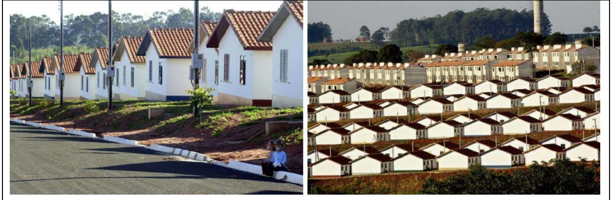
Figura 01. Conjunto Habitacional em Avaré - SP
