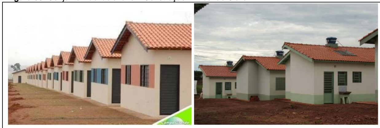
Figura 08. Conjunto Habitacional em Construção – Ribeirão Claro
