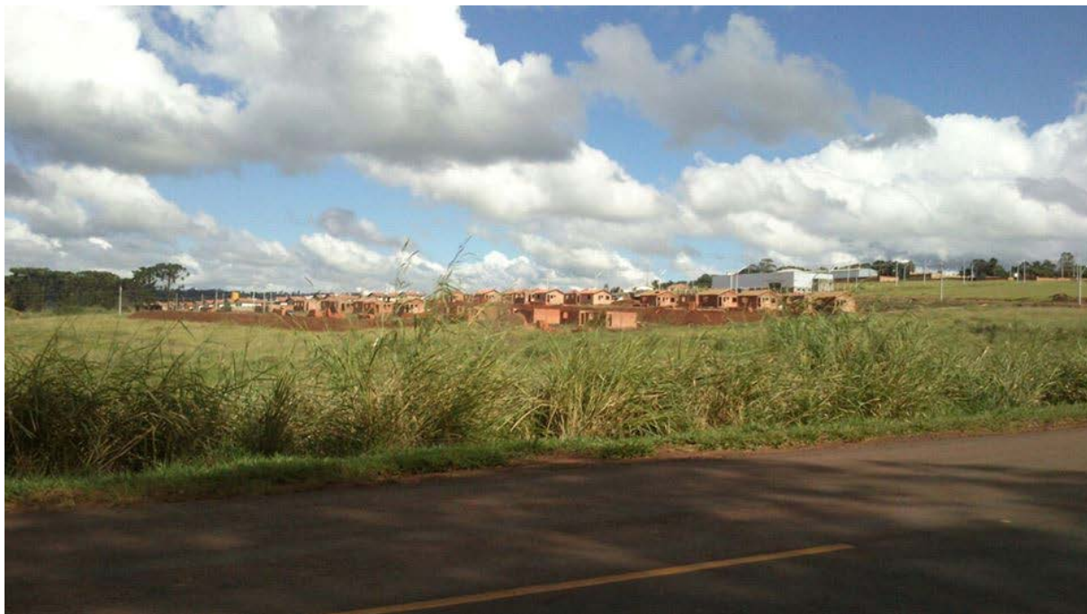
Figura 07. Conjunto Habitacional em Construção – Ribeirão Claro
