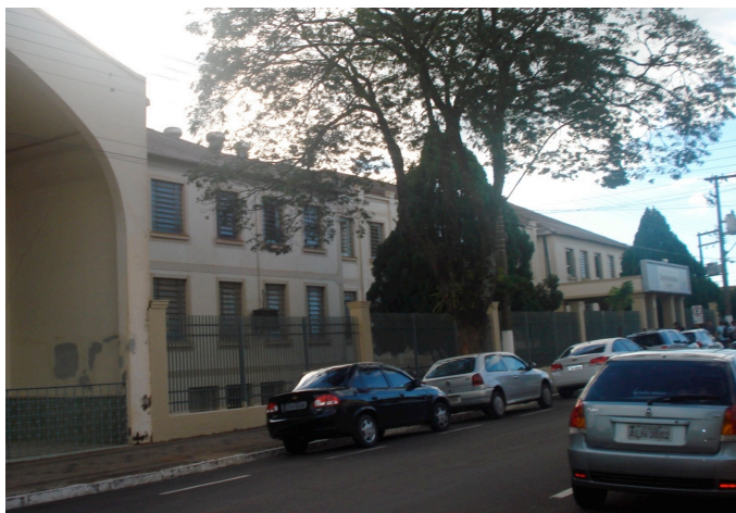
Figura 1. Fachada do Colégio Santo Antônio Objetivo. Fonte: Mello, Jéssica Luana de Oliveira - 07/05/2012.
