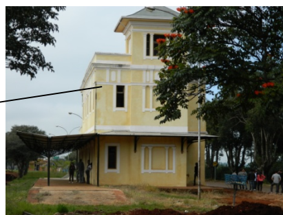
Imagem 08 – Estação Ferroviária de Piraju Fonte: os autores (2012).
