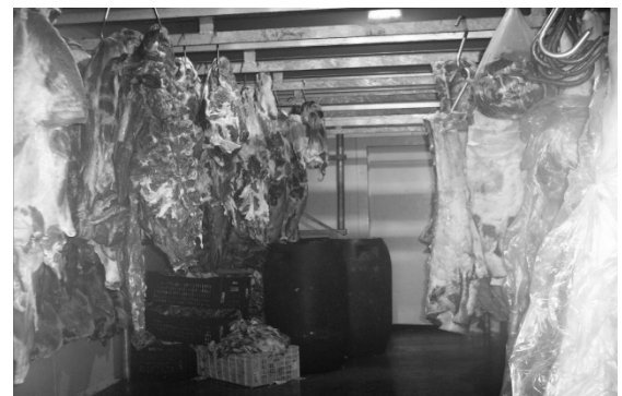
Figura 6 – Diagnóstica câmera de refrigeração de carnes.
